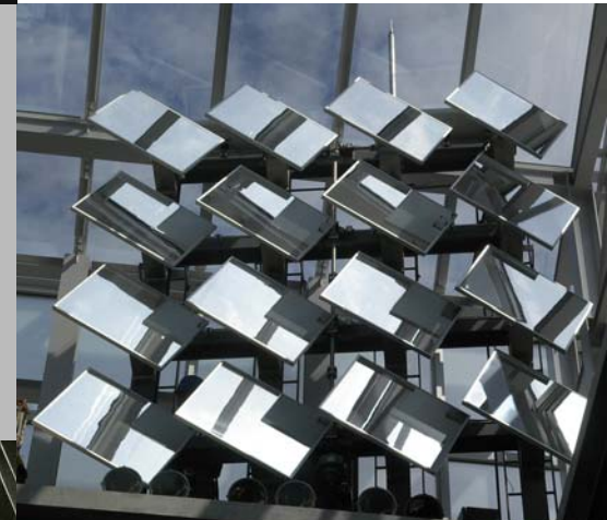
太陽光自動追尾型の1次ミラー 太陽追尾1次ミラー：大成建設株、機アクス共同開発。特許出願中
